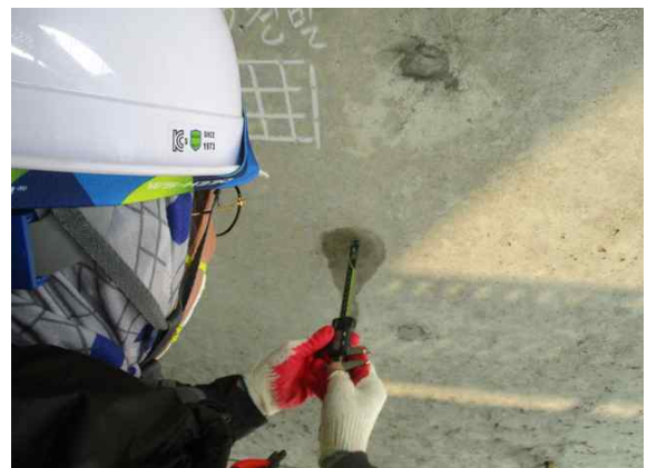
b. 탄산화 깊이 측정
